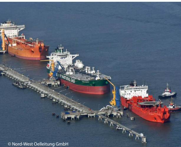
© Nord-West Oelleitung GmbH
