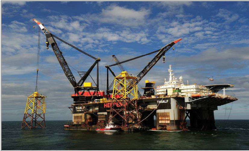
Abbildung 63: Halbtaucher-Schwerlastplattform Thialf bei der Errichtung eines Jacket-Fundaments im Offshore-Windpark alpha ventus
