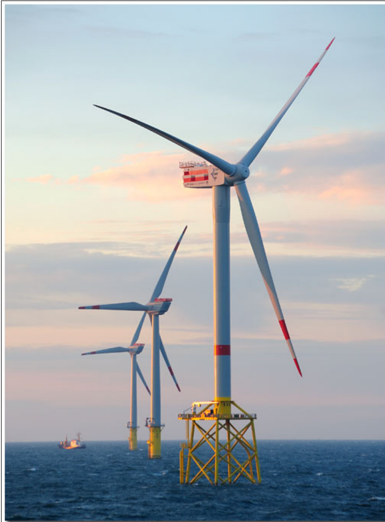
Abbildung 56: Offshore-Windpark alpha ventus mit zwei unterschiedlichen Fundamenttypen: vorne: Jacket-Fundamente, hinten: Monopiles
