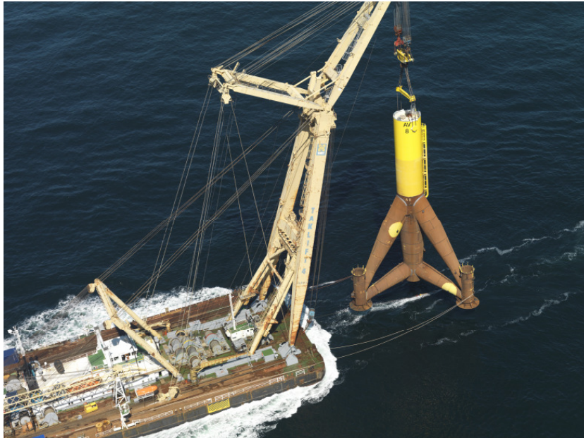
Abbildung 64: Der Schwimmkran „Taklift“ mit einem Tripod-Fundament für den deutschen Offshore-Windpark alpha ventus
