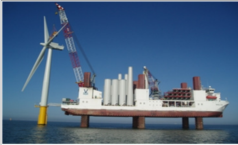
Abbildung 66: Jack-Up Barge bei der Installation einer Offshore-Windenergieanlage
